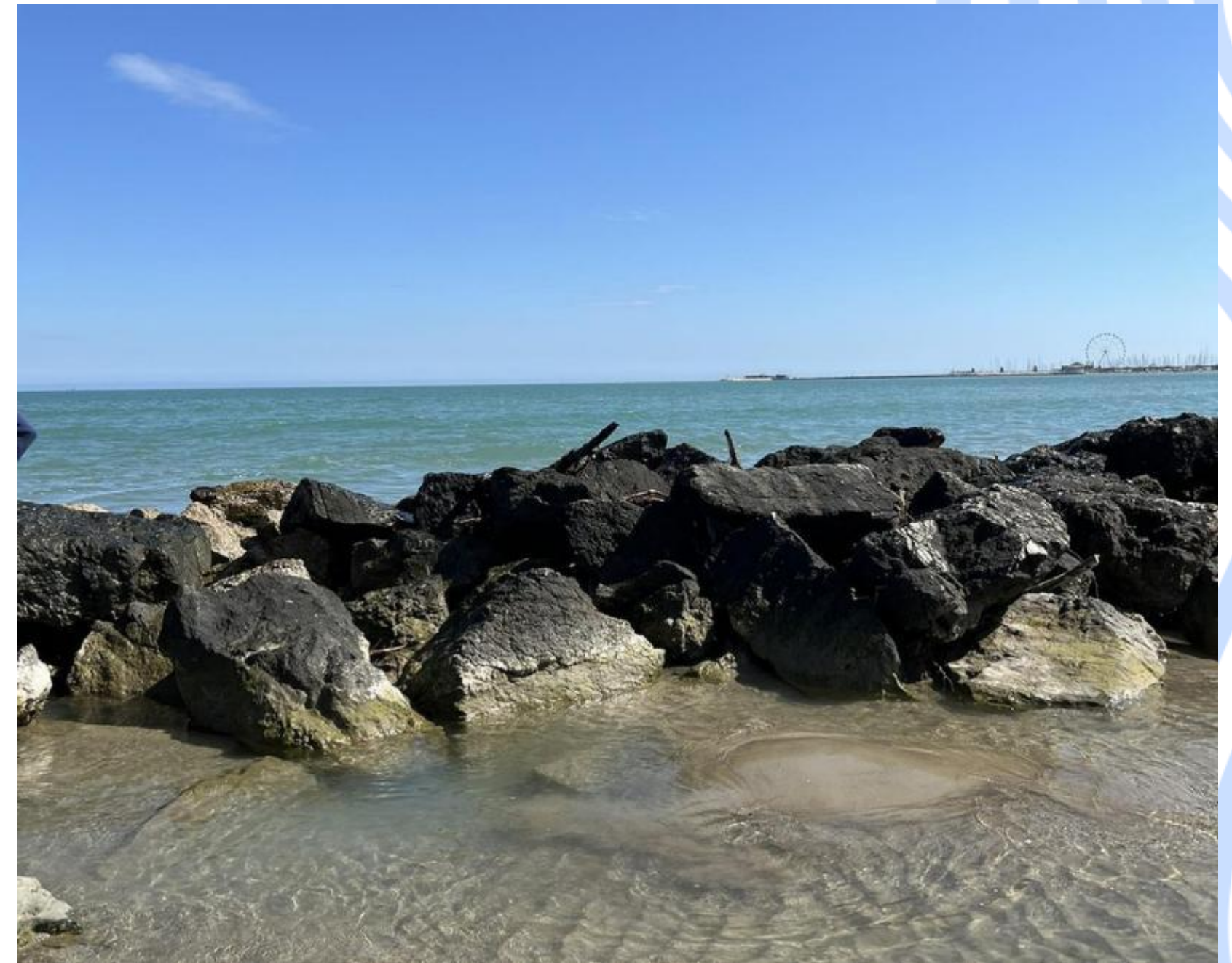
Naturalne bloki skalne ułożone wzdłuż linii brzegowej chronią przed ekspansją morza.
